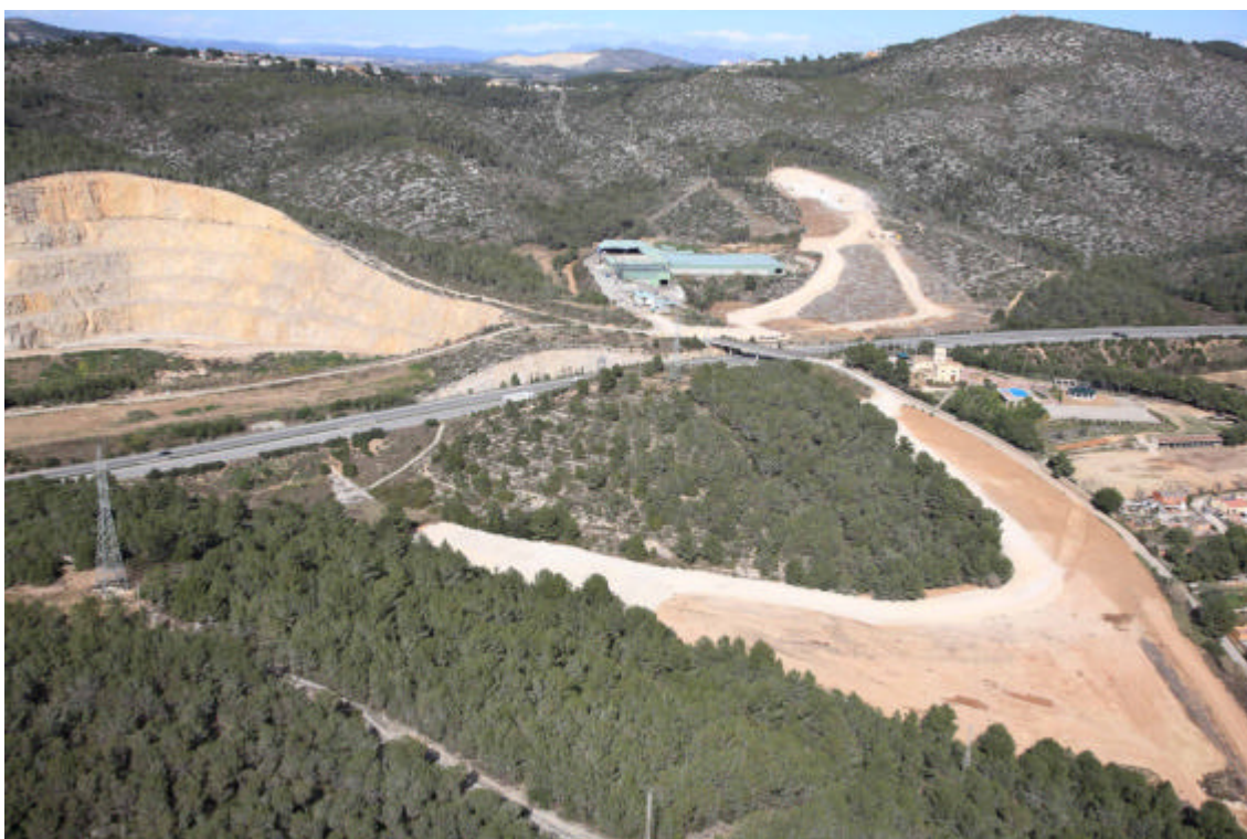
Obres enllaç amb la C-32
